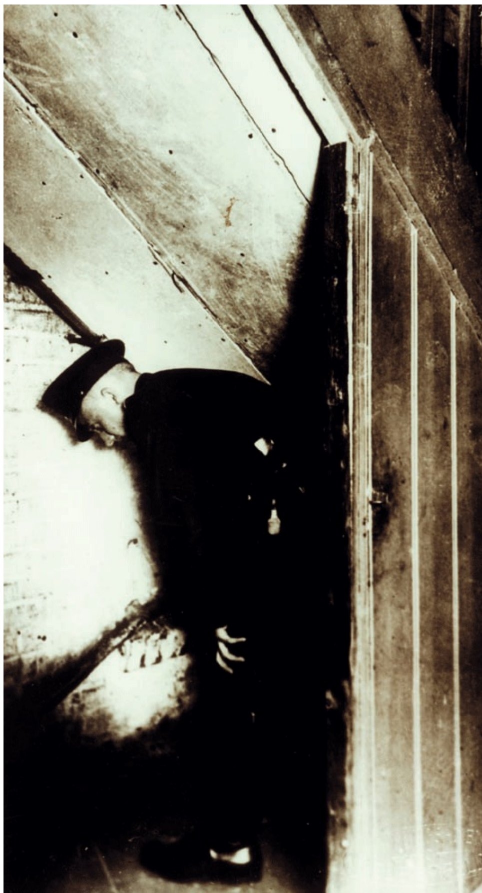
Der Treppenverschlag im KZ Kemna, 1934
